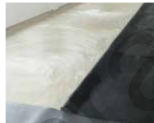
Instalare cu tehnica dubla taiere
