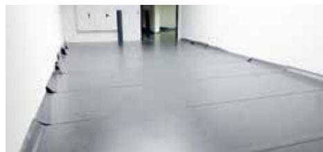
Instalare cu tehnica dubla taiere
